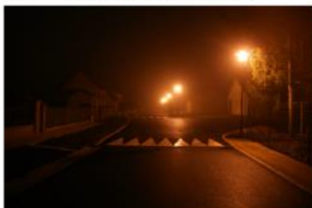
Rue de la Gare : lampadaires récents
