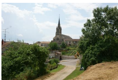
1) Vue sur l'église depuis les vergers
